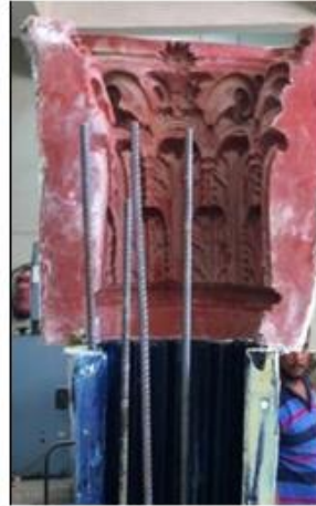
شكل (١٦) يوضح شكل قالب لعمود روماني كورنثي تم تسليحه بحديد التسليح تمهيدا لصب عامود إنشائي زخرفي
