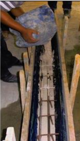
شكل (١٨) يوضح شكل قالب لكمره إتصل بها مفردة زخرفية (كورنثي) وتم تسليحها بحديد التسليح
