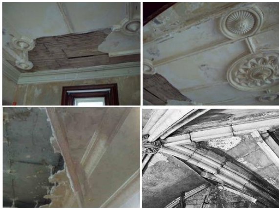
شكل (٩) يوضح سقوط العناصر الزخرفية الجبسية بمرور الوقت. المصدر: [٢١]
