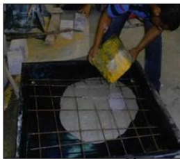
شكل (١٧) يوضح شكل قالب لبلاطة سقف إتصل بها مفردة زخرفية (سوره) وتم تسليحها بحديد التسليح
