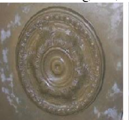
شكل (١٩- أ) يوضح بلاطة خرسانية مسلحة تم ربط العنصر الزخرفي مع الإنشائي من خلال استخدام زخارف من نبات الأكتنس الروماني في تنفيذ الحلية المعمارية والتي إعتاد البعض تنفيذها بالجبس.
