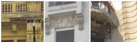
شكل (١١) يوضح تساقط العناصر الزخرفية بمرور الوقت بمباني وسط البلاد. المصدر: (الباحث)
