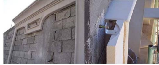
شكل (٣) إحدى الكرانيش لسور وقد تم تثبيت الحجر بالزاوية مع استخدام أدوات التثبيت المعدنية. المصدر: [٢١]
