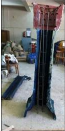
شكل (١٦) يوضح شكل قالب لعمود روماني كورنثي تم تسليحه بحديد التسليح تمهيدا لصب عامود إنشائي زخرفي
