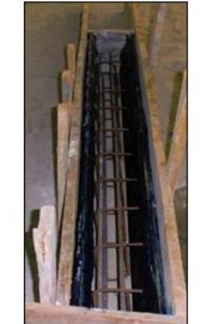
شكل (١٨) يوضح شكل قالب لكمره إتصل بها مفردة زخرفية (كورنثي) وتم تسليحها بحديد التسليح
