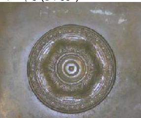
شكل (١٩- أ) يوضح بلاطة خرسانية مسلحة تم ربط العنصر الزخرفي مع الإنشائي من خلال استخدام زخارف من نبات الأكتنس الروماني في تنفيذ الحلية المعمارية والتي إعتاد البعض تنفيذها بالجبس.
